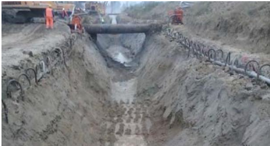
Figura 18 – Esempio di drenaggio di trincea con doppia fila di wellpoint
